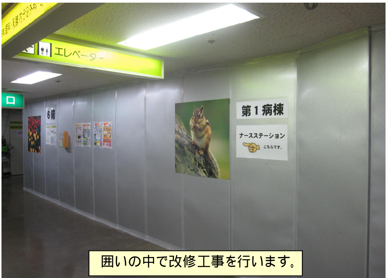
ナースステーション前(改修工事前)
